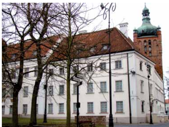
Budynek dawnego opactwa benedyktyńskiego – od 2008 r. siedziba Muzeum Diecezjalnego w Płocku
